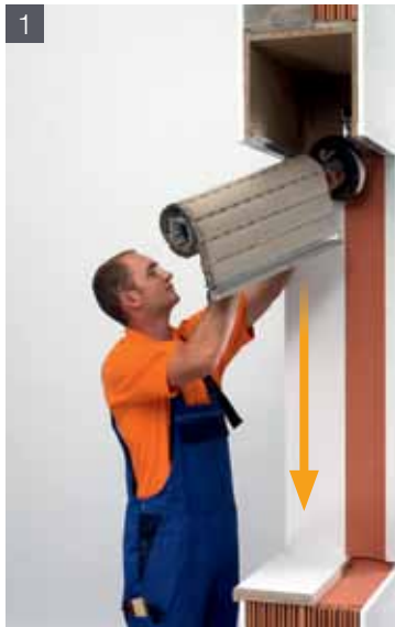
1 Alten Rollläden aus Kasten entfernen!
